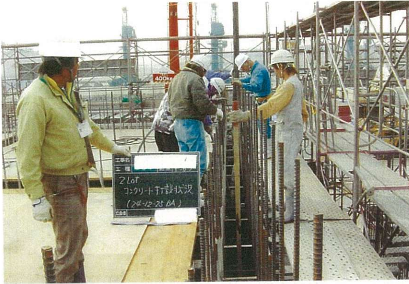
コンクリート打設 状況
